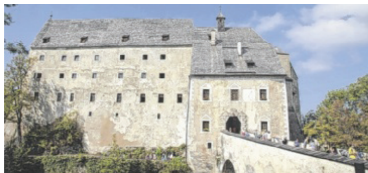
Die Burg Altpernstein wird derzeit generalsaniert.
